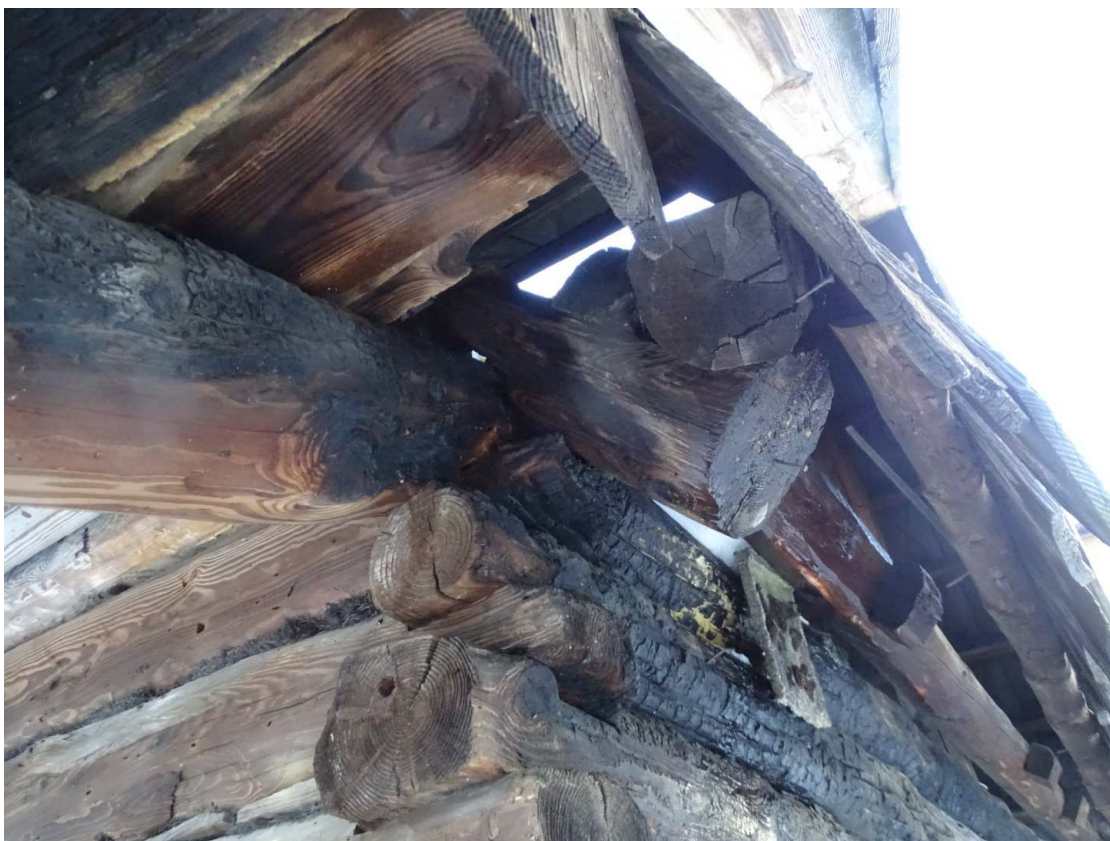
Fot.[10]. Narożnik zwieńczenia ściany północno-zachodniej. Korozja wywołana zgnilizną brunatną. Fot. autor.
