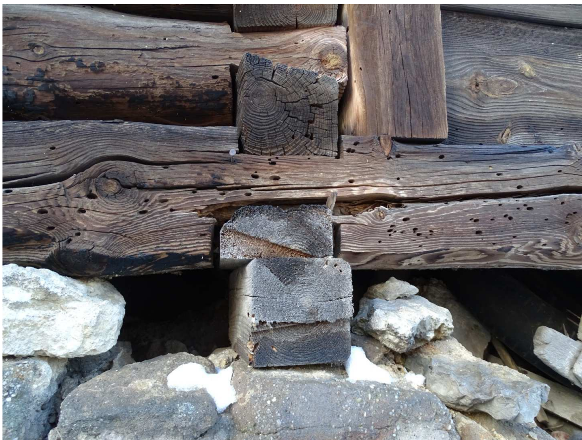
Fot.[19] Spuszczel pospolity – Hylotrupes bajulus - opuszczone otwory owadzie w belkach ściany południowej. Fot. autor.
