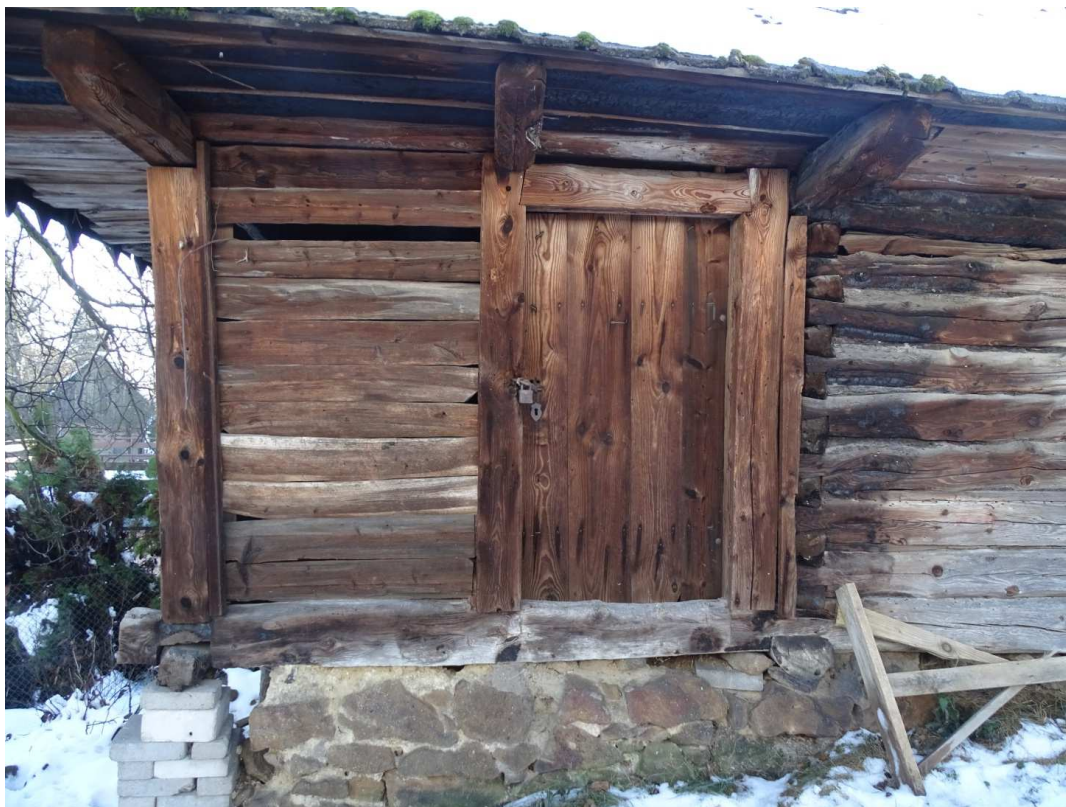
Fot.[15] Elewacja północna. Widoczny rozwój grzyba powłocznika gładkiego ( Corticium laeve )
