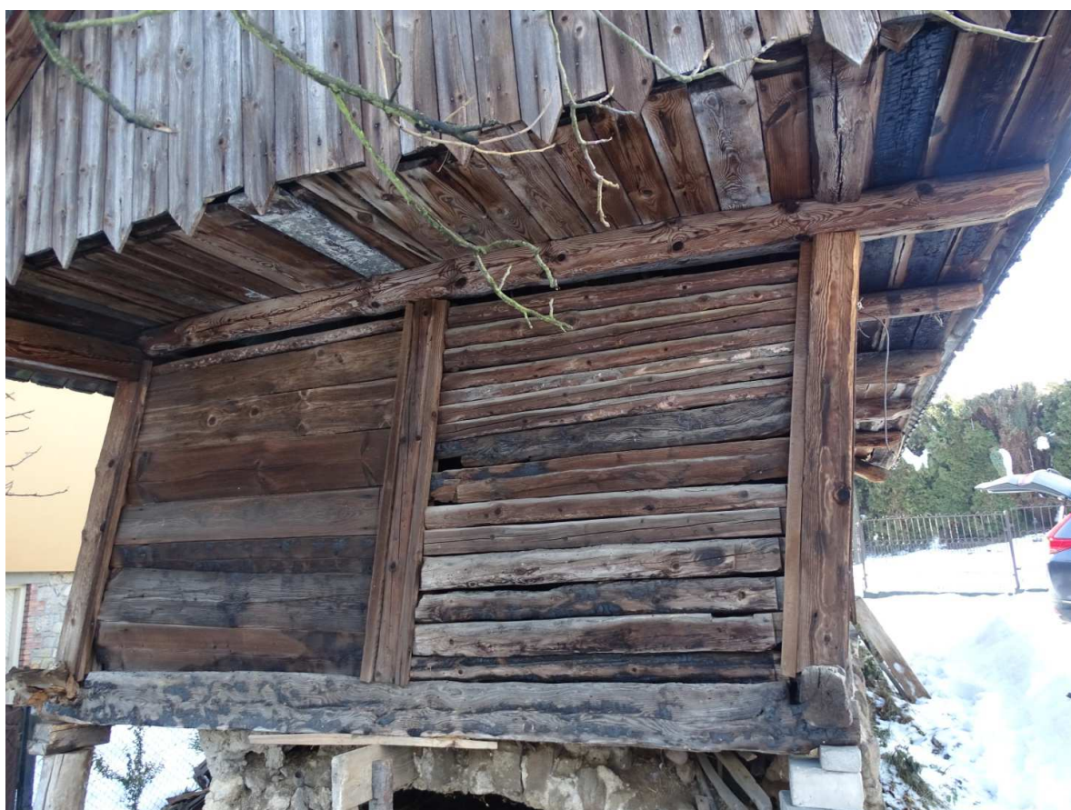
Fot.[14] Elewacja wschodnia. Widoczny rozwój grzyba powłocznika gładkiego ( Corticium laeve ) Fot. autor.
