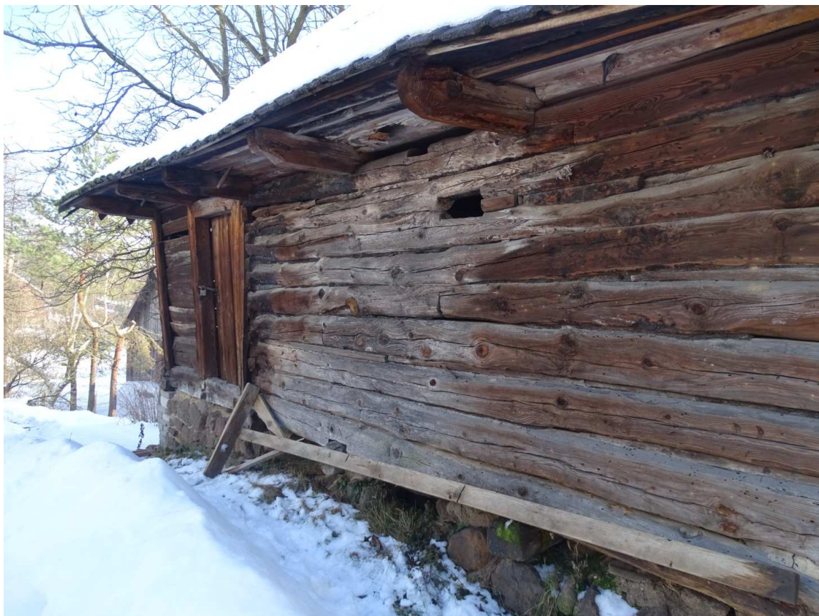
Fot.[13] Elewacja północna. Widoczny rozwój grzyba powłocznika gładkiego ( Corticium laeve ) Fot. autor.
