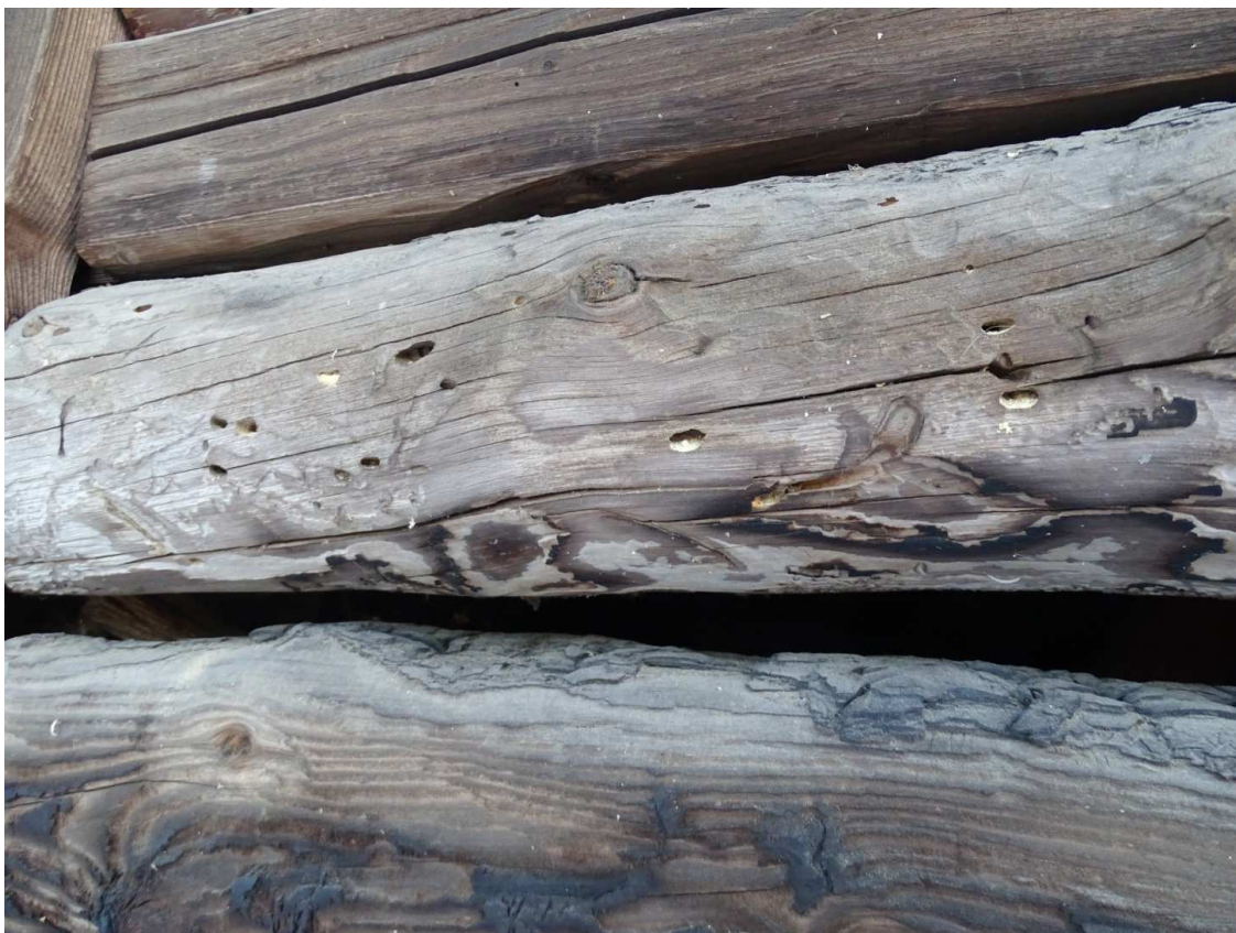
Fot.[17] Spuszczel pospolity – Hylotrupes bajulus - zaatakowane lokalnie belki ściany południowej. Wysyp świeżej mączki drzewnej świadczy o aktywności owadów. Fot. autor.
