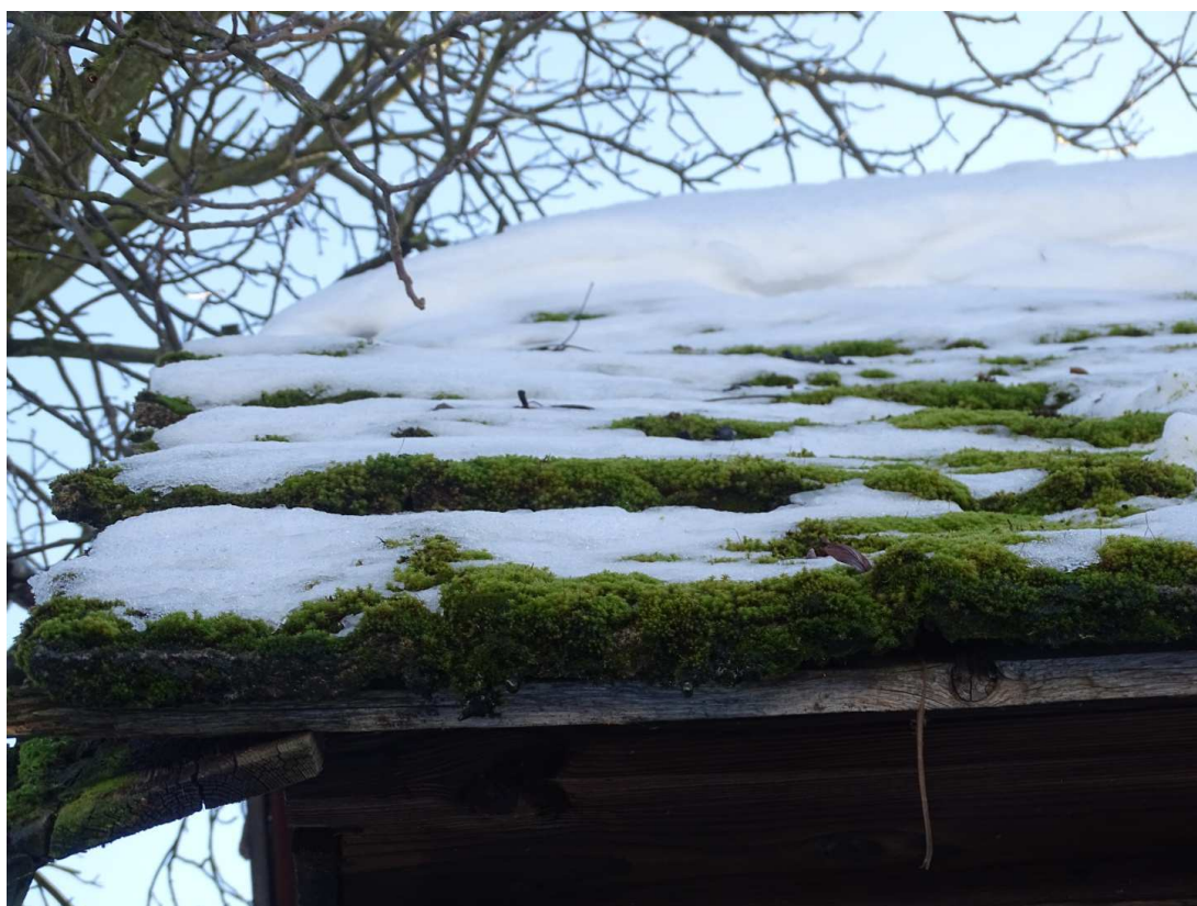
Fot.[16] Pokrycie dachowe porażone mchami. Fot. autor.
