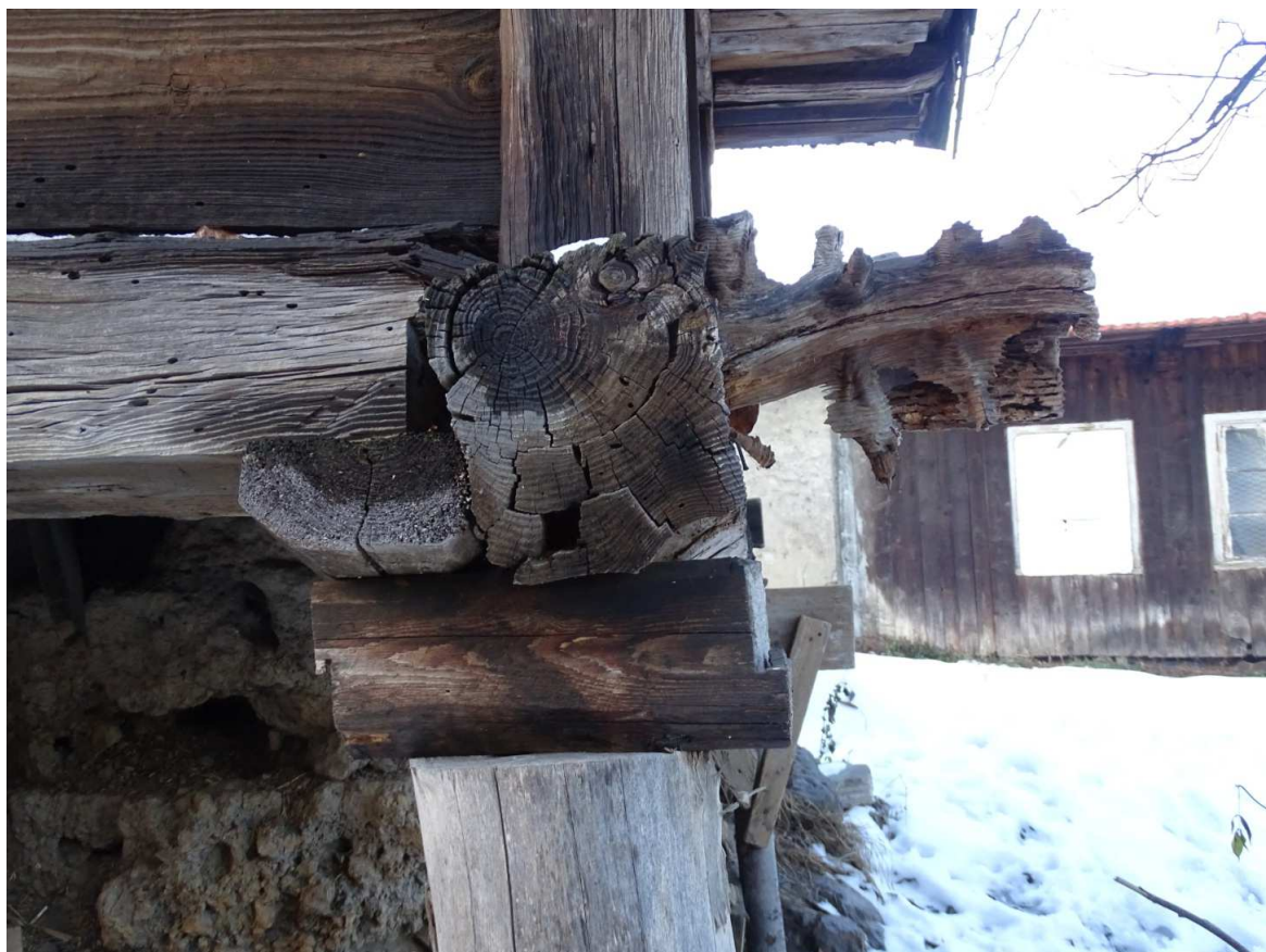
Fot.[9] Podwaliny ścian zewnętrznych. Widoczna zgnilizna brunatna wywołana przez grzyba domowego właściwego ( Serpula lacrymans ). Fot. autor.
