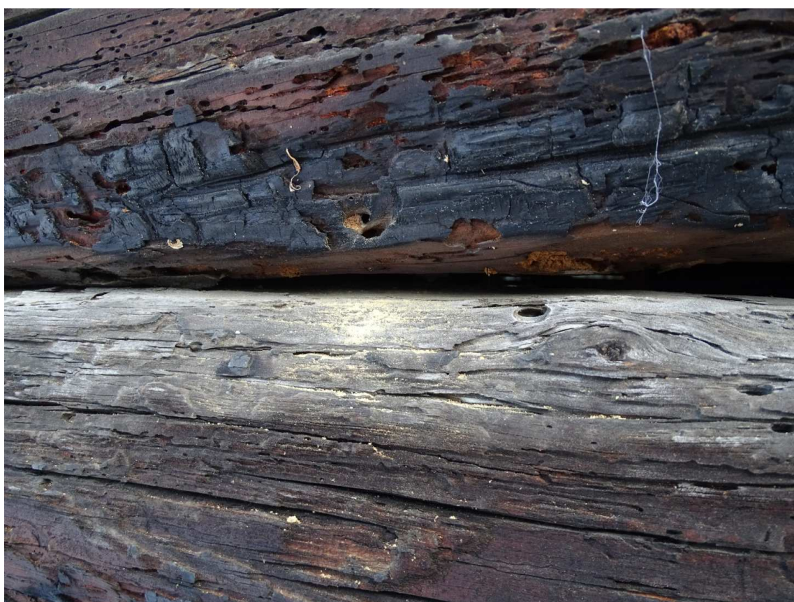
Fot.[18] Spuszczel pospolity – Hylotrupes bajulus - zaatakowane lokalnie belki ściany południowej. Wysyp świeżej mączki drzewnej świadczy o aktywności owadów. Widoczne również mniejsze otwory żerowisk owada Kołatka domowego ( Anobium punctatum ) z brakiem obecności owada. Fot. autor.
