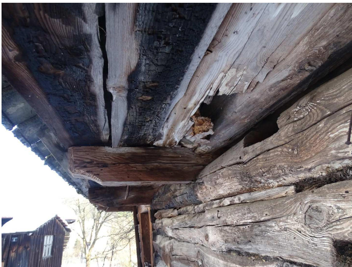
Fot.[11] Deski podbicia okapu - widoczne uszkodzenie zgnilizną brunatną wywołaną przez grzyby domowe. Fot. autor.
