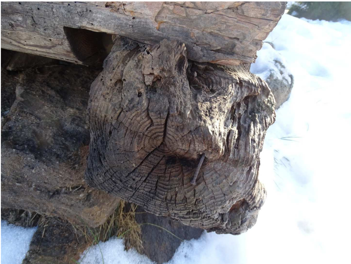
Fot.[8] Podwaliny ścian zewnętrznych. Widoczna zgnilizna brunatna wywołana przez grzyba domowego właściwego ( Serpula lacrymans ). Fot. autor.
