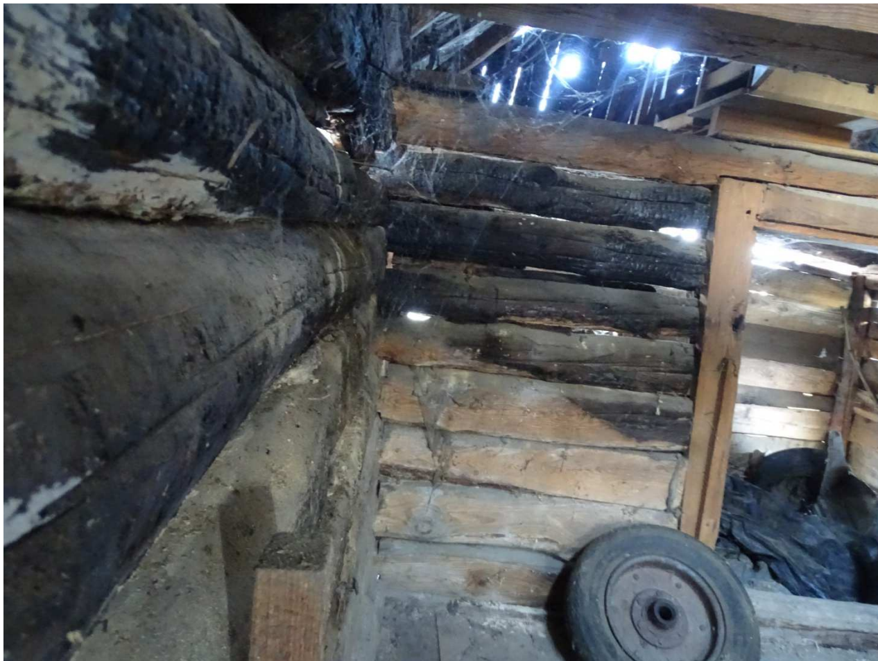
Fot.[12] Zwieńczenie ściany północnej w okolicach uszkodzenia dachu. Widoczna zgnilizna brunatna wywołana przez grzyba domowego właściwego ( Serpula lacrymans ). Fot. autor
